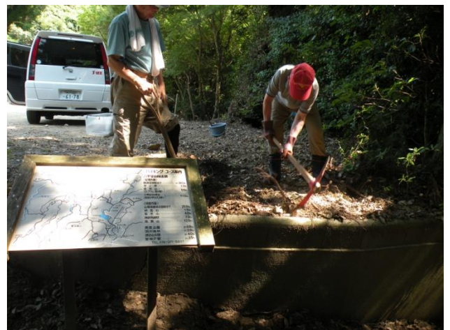
設置の為の作業（穴掘り）
