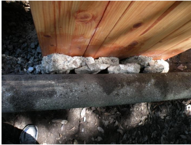
大小のバラスを入れコンクリートと土で調整する
